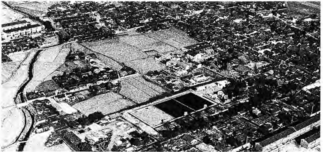
空から見た町裏水源地 (昭和35年ごろ)
