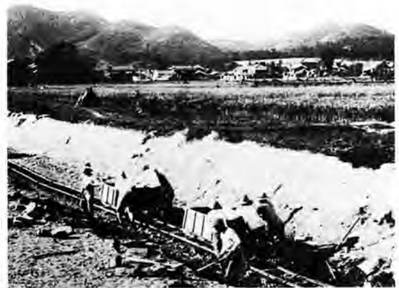
町裏水源地の工事 『姫路市水道誌』
