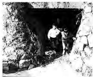
排水口 水車を回した水は、手前の船場川へ流れ出る。排水口の天井には厚い石を渡して上が道になっている。
