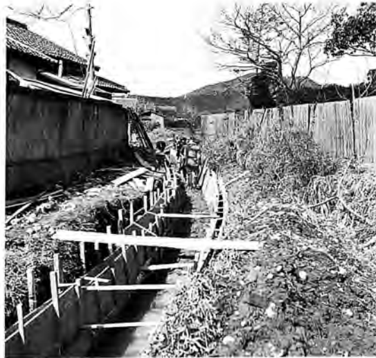
宅田ゆ（車溝）の護岸工事（昭31.1 矢内 写）
