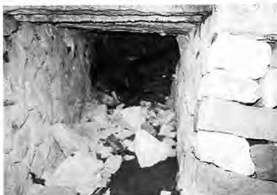
田摩水車の地下水路 (昭62.12 矢内 写)
